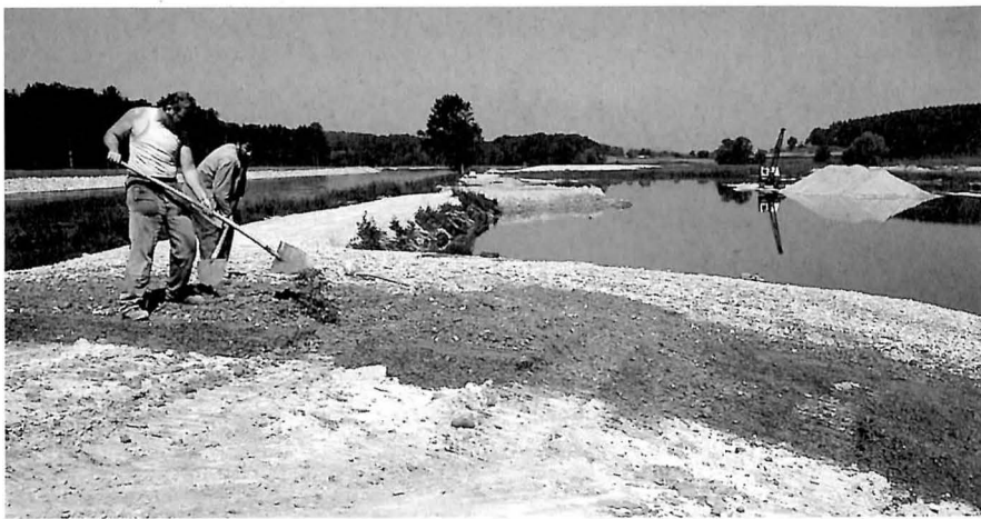
Unterer Teil der Insel 600, Mörtelunterzug zur Minderung des Bewuchses in Arbeit (14.7.75).
