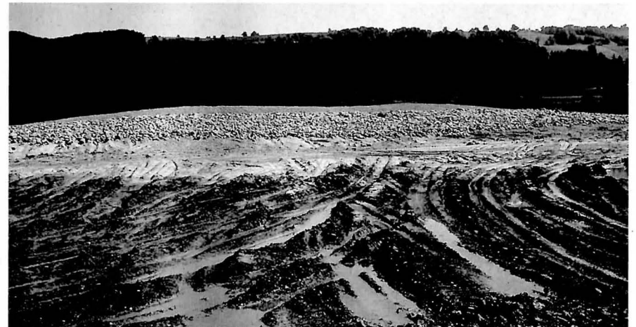
Fertigeschüttete Insel 300 mit strömungsseitigem Blockwurf «noch auf dem Trocknen». (6.6.75).
