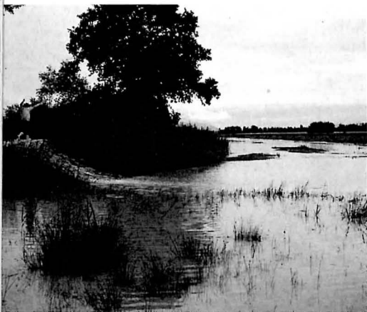
Überspülte Dammkrone bei Aristau (alter Hochwasserdamm)
