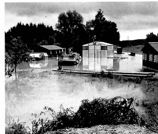
Überfluteter Bauinstallationsplatz Rottenschwil
