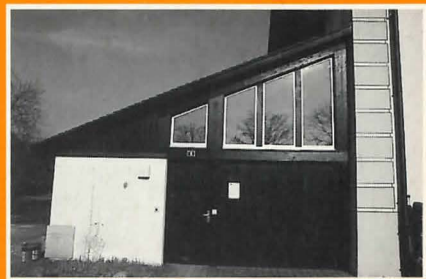
Die neuen Fenster am Vorbau (Eingangshalle) machen den Kursraum heller und freundlicher.
