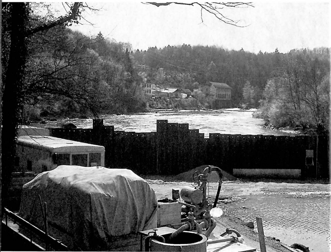
Abb. 1: Baustelle des Kraftwerks Bremgarten-Zufikon am 3. Mai 1972. Zuvor hatte das Bundesgericht die für den Bau erforderlichen Rodungen freigegeben. Im Hintergrund ist noch die alte Kraftwerkanlage von 1893/94 zu erkennen, eine technische Pionierleistung der Firma Escher Wyss in Zürich. (Foto E. Kessler)
