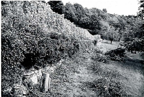
Eine völlig überwucherte und zum Teil zerfallene Rebmauer wurde freigelegt und neu aufgebaut. FOTOS: zvg
