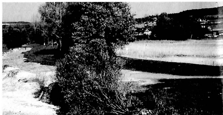
Abb. 2: Revitalisiertes Reussufer nördlich der Obfelder Brücke (Bildmitte und Hintergrund). Auf rund 200 Metern Länge ist der harte Uferverbau entfernt – im Bildvordergrund in Brückennähe zum Schutz der Brückenfundamente noch bestehend – und das Vorland ist auf einer Breite von 10–12 m leicht abgesenkt. Die weitere naturgerechte Gestaltung obliegt jetzt wieder der Reuss und der sich spontan einstellenden Vegetation.
