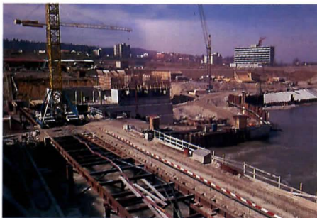
Kraftwerk Bremgarten im Bau
