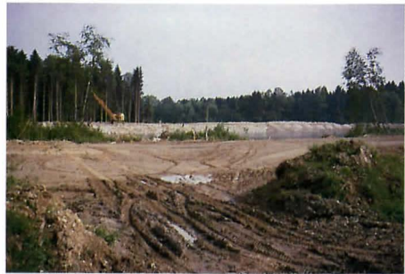
Waldrodungen und Dammbau
