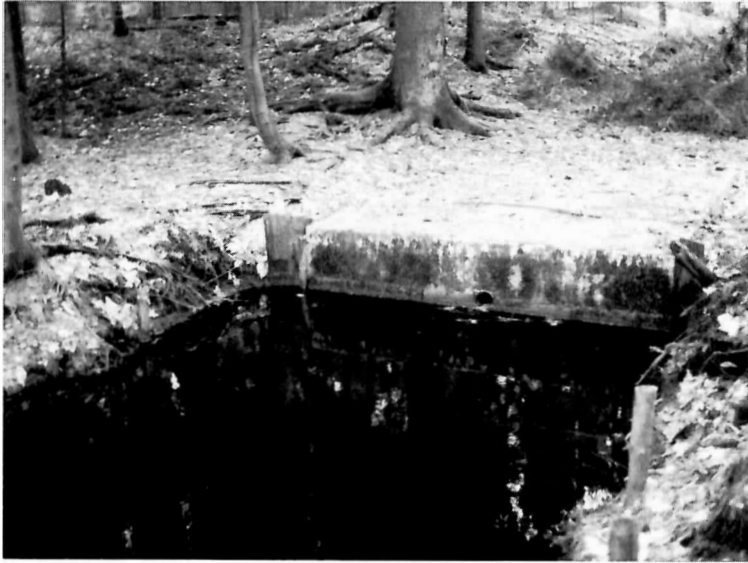
Abb. 5 Das vom Gemeindegewerk 1979 erstellte Überlaufwerk mit drei übereinanderliegenden Röhren
