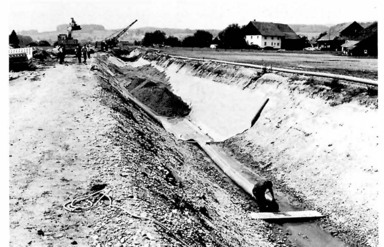
Abb.2 Die baulich aufwendige Abdichtung des Reusskanals A 6 (Einlegen einer Folie auf einer Strecke von 775 Metern Länge) ist in Mühlau anfänglich auf Widerstand gestossen. Die Massnahme war jedoch notwendig, um nachteilige Auswirkungen der Sohlenabtiefung auf die empfindliche, stark grundwasserabhängige Vegetation des Schorenreservates zu verhindern.
