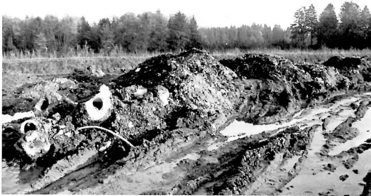
Abb.5 Rechtswidrig angelegte Bauschuttdeponie in einer Riedwiese, die zwar nicht zum Schutzkonzept gehört, die aber für Verpflanzungszwecke reserviert worden war. Über den Erfolg einer Restverpflanzungsaktion, die mit Hilfe des Unternehmers durchgeführt wurde, kann noch keine Aussage gemacht werden (Aufnahme vom 22. November 1980).
