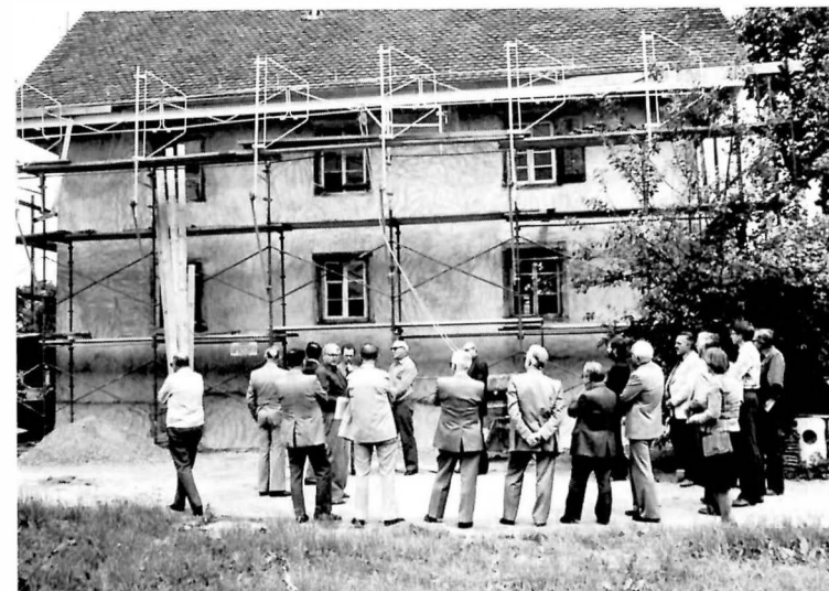
Abb.7 Jahresversammlung vom 21. Juni 1980: Architekt Ernst G. Streiff erläutert dem Stiftungsrat den Fortschritt der Renovationsarbeiten. Fotos: E. Kessler
