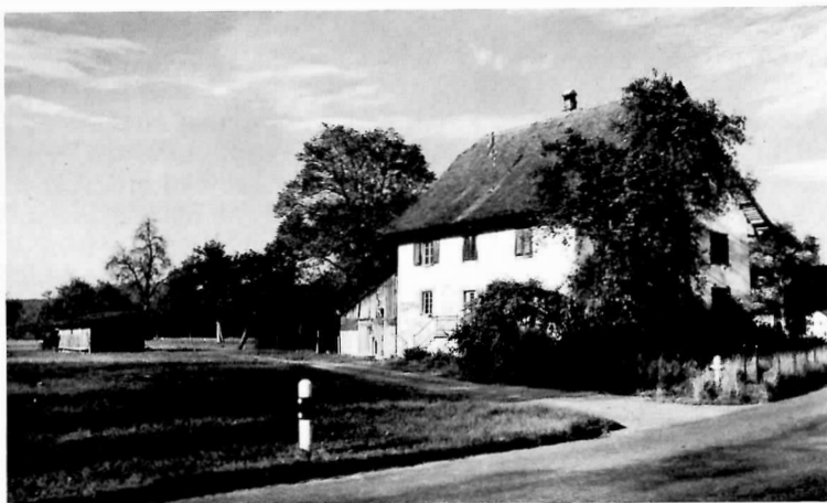
Abb. 1 Zieglerhaus Rottenschwil («Haus 53») vor der Renovation: Das Jahr 1979 brachte den erhofften Grundsatzentscheid zugunsten des geplanten Informationsstützpunktes in Rottenschwil, einem Gemeinschaftswerk von Kanton, Bund und privaten Naturschutzorganisationen, das auch für eine Zusammenarbeit mit der Gemeinde offen ist. Mit der neuen Zweckbestimmung des Gebäudes ergibt sich zugleich die Möglichkeit, wertvolle Freiamter Bausubstanz zu erhalten.
