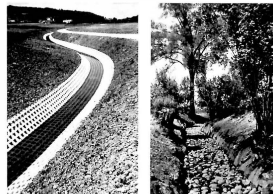
Abb. 4 Ausschnitt aus der Versuchsstrecke bei Werd: Die Verwendung von Gittersteinen beim Kanalbau ermöglicht den Kontakt des Fliessgewässers mit dem Bodenwasser wie auch eine allmähliche Begrünung der Betonelemente (Aufnahme kurz nach dem Verlegen, Bepflanzung noch fehlend).
